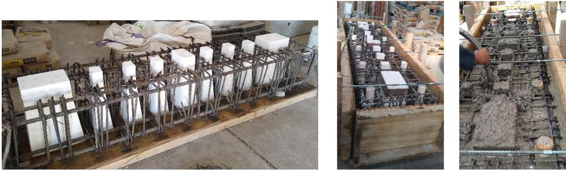
**Figura B.1 Construcción de una viga de cimentación adicional**
