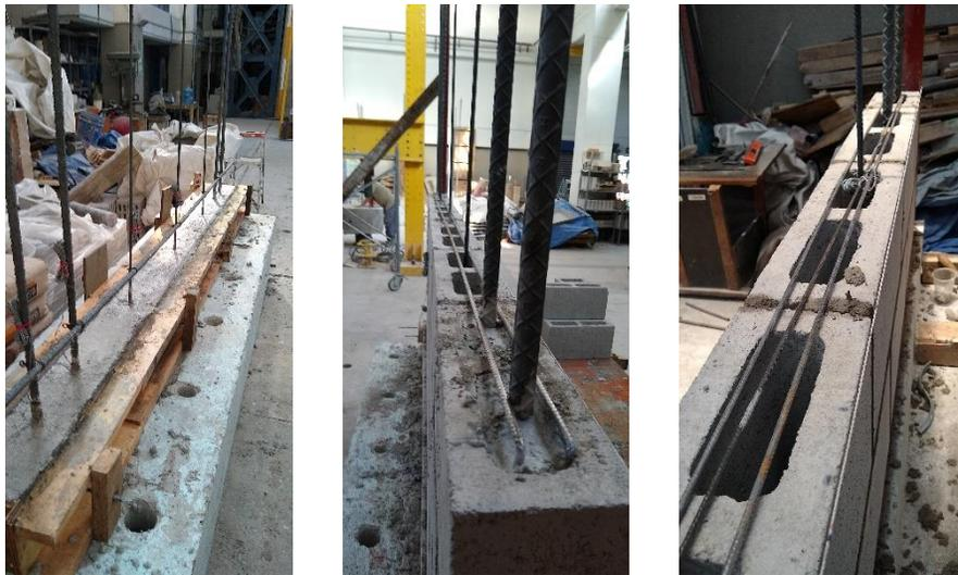
**Figura B.5** Anclaje a la base del refuerzo vertical, relleno de piezas y colocación de dos o tres alambres horizontales
