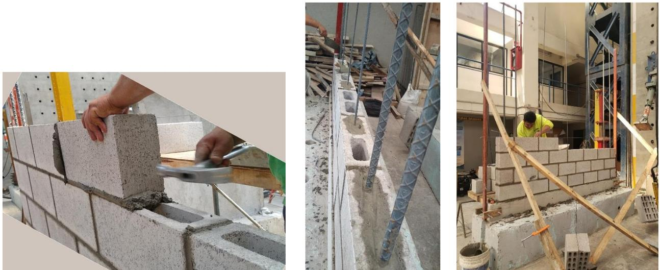
**Figura B.6** Construcción de las hiladas de mampostería
