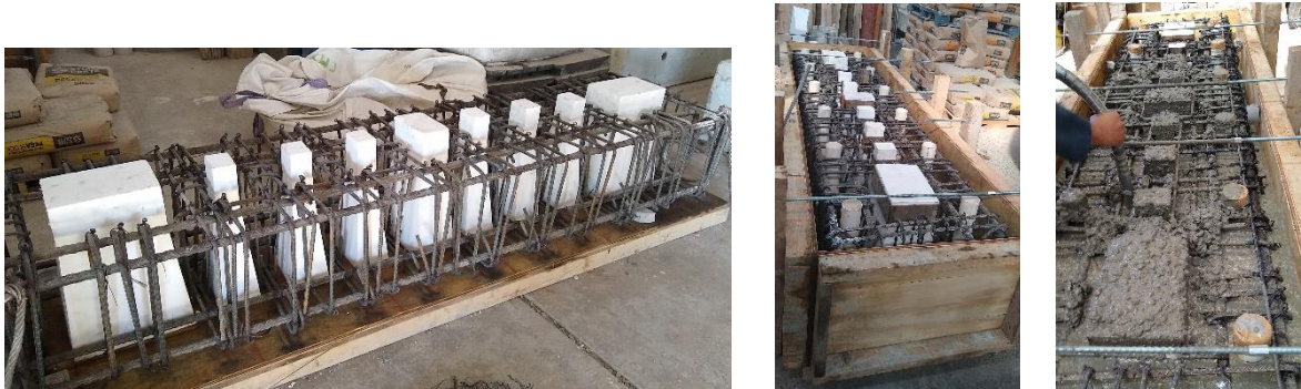
Figura B.1 Viga de cimentación nueva
