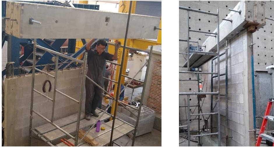
Figura B.5 Colocación del cabezal superior y muro terminado
