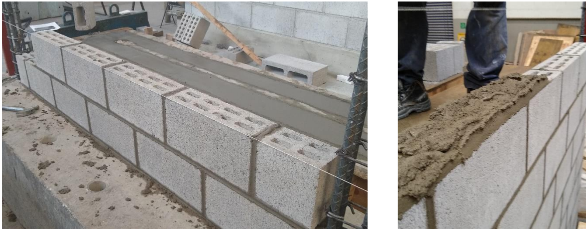
Figura B.3 Pegado de las piezas del muro con mortero tipo I, o con mortero industrializado premezclado
